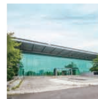
南科分公司 (南部科學園區) Southern Taiwan Science Park Branch STSP Factory III
